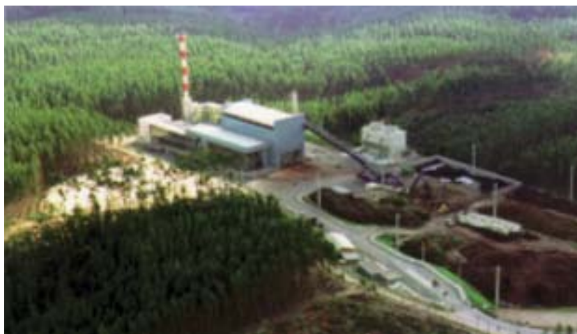
Fig 293: Central eléctrica de Mortagua, en el área de Coimbra.
