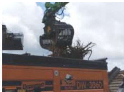
Fig. 13: carga de tocones en máquina pretrituradora.
