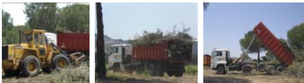
Figuras 259,260 y261: Trabajo de acopio de la pala cargadora Volvo BML50 y los camiones volquete.
