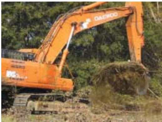
Figuras 190 y 191: Retroexcavadora extrayendo tocones (izquierda) y volquete de áridos durante el acopio.
