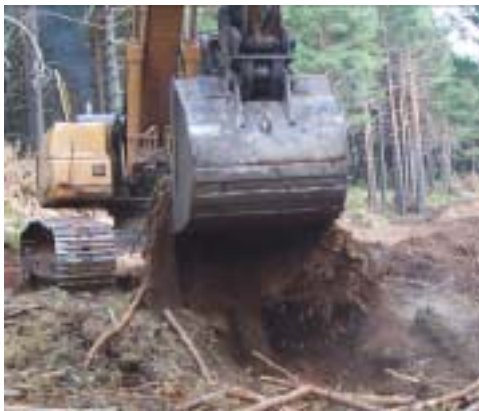
Figuras 185 y 186: Trabajo de la retroexcavadora en la extracción de tocones
