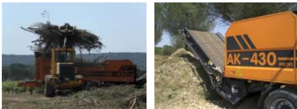
Figuras 262 y 263: Alimentación de la trituradora Doppstadt AK 430 con la cargadora BML 70.
