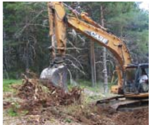
Figuras 185 y 186: Trabajo de la retroexcavadora en la extracción de tocones
