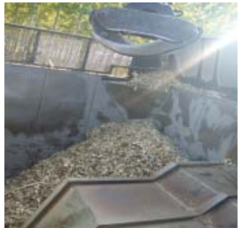
Figura 252: Interior del container de la astilladora y cabezal de grúa plegado.
