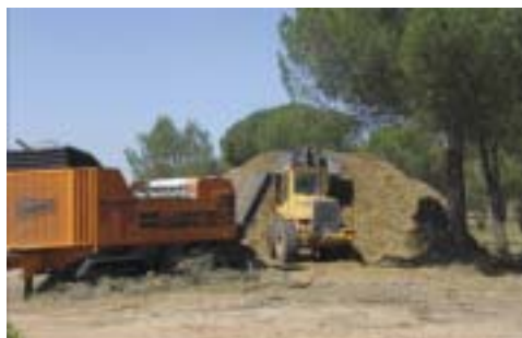
Figura 265: Cargadora retirando la biomasa triturada de la zona de desahogo de la cinta transportadora de la trituradora.
