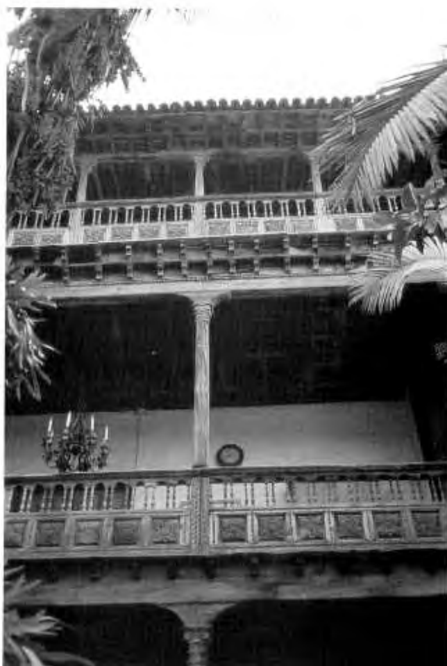
Balconada interior de tea de la Casa de los Balcones de La Orotava (Tenerife), construida en el siglo XVII. (Foto: J. Climent.)
