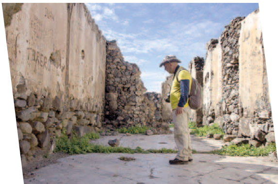
Restos del almacén de la empresa Fyffes
